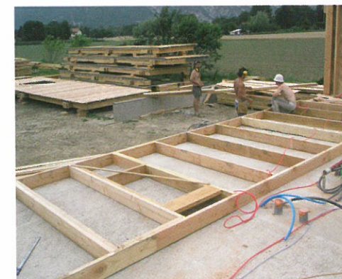
Assemblage des ossatures sur la dalle du rez-de-chaussée (photo Caracol architecture).
