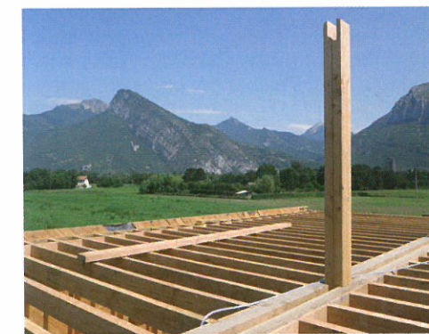
Poteaux et solives sont en place. Dès que les plaques du plancher seront posées, le contreventement horizontal du bâtiment sera assuré (photo Caracol architecture).
